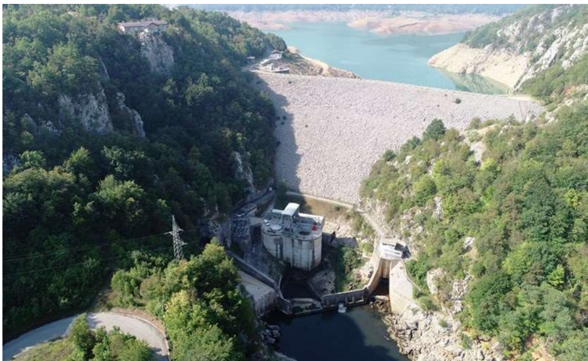
Slika 14: Prikaz hidroelektrane Sklope
