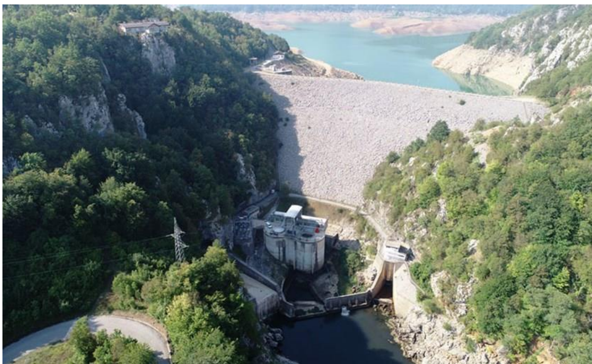
Slika 12: Prikaz hidroelektrane Sklope
